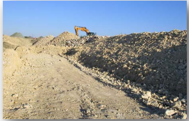
Fig.1. Calcaire kimméridgien mis au jour par les terrassements
